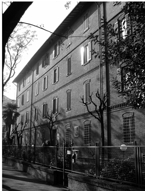
Figure 15: Bologna, Società Anonima Cooperativa per la Costruzione e il Risanamento di Case per gli Operai: Fabbricato C , in via Zambeccari
